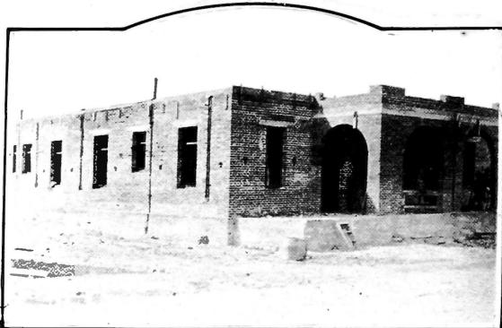
Casas en construcción para oficiales.
